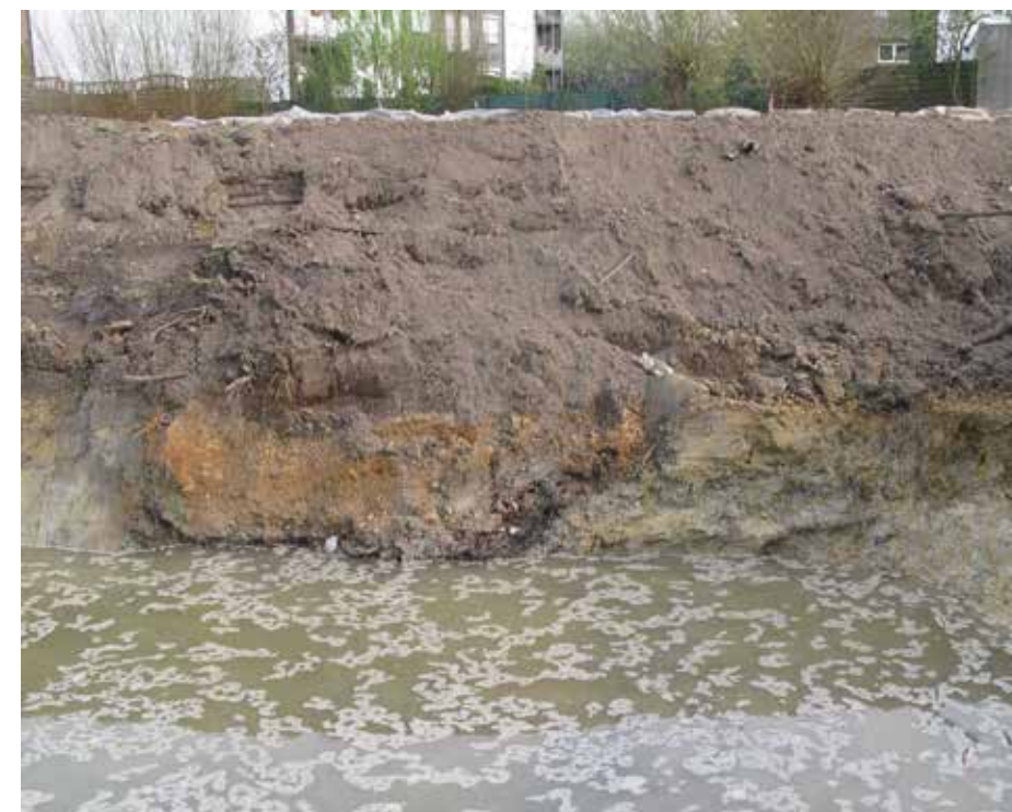
Baugrube mit angeschnittenem Graben im Profil, Foto: Weynans
